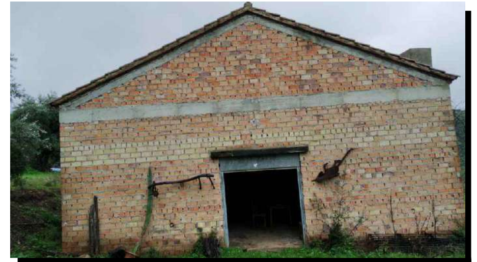
FACHADA LATERAL IZQUIERDA (2)
